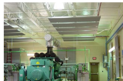
Fot. 5. Baffle pod sufitem hali autoserwisu
