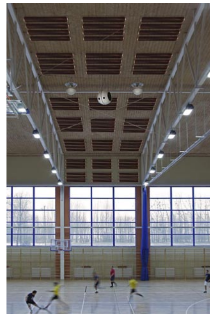
Fot. 3. Hybrydowe „walce” pod dachem w hali sportowej
