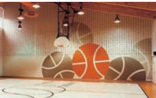
Sala sportowa zbudowana z bloków akustycznych
